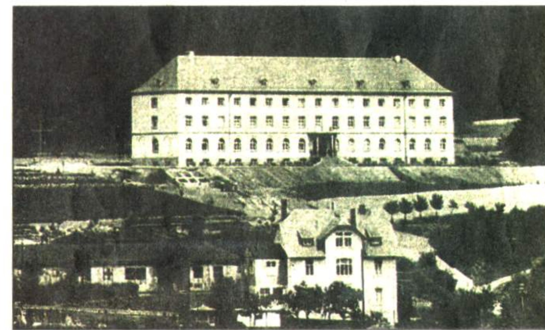
Konvikt mit Notkirche links, darüber die neue Heimat der Patres kurz vor der Fertigstellung.
